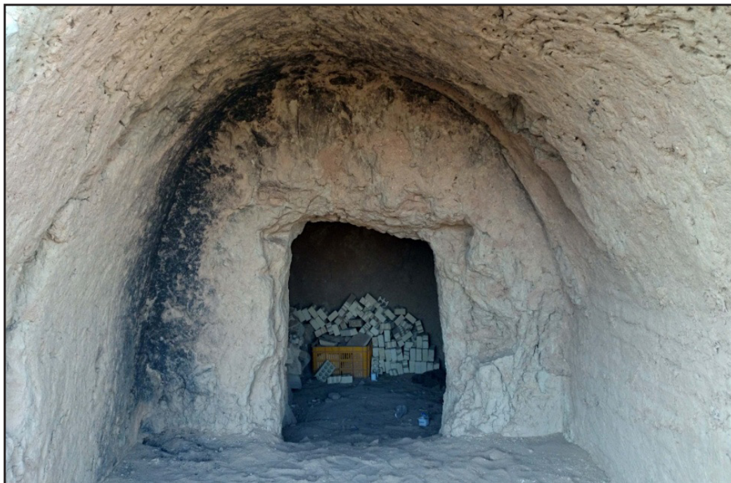
تصویر ۲۱. قوس بیضی یکی از اتاق‌های بوکن مردم‌نشین (عکس از: نگارندگان).
